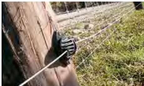
Figura 5 Izolator simplu Foto:IM
