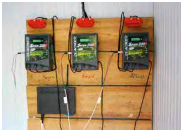
Figura 2 Generatoare electrice Foto:IM
