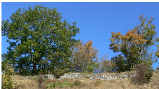
Fig. 19. Ruinele zidurilor cetăţii Foto: Mihai Zup, 2011.
