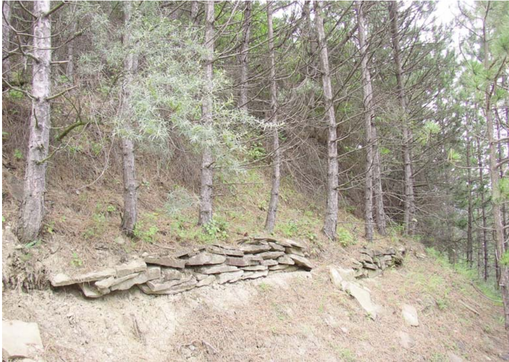
Foto 1.3. Plantație de pin în amestec cu cătină albă pe terase din zidărie de piatră în perimetrul experimental Bârsești, Vrancea (C. Constandache, 2005)
