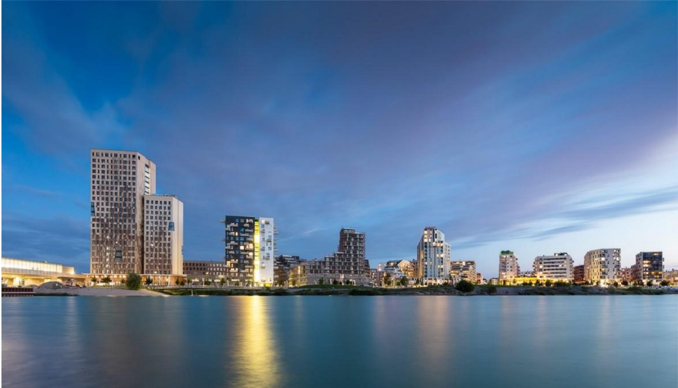
Figura 37. Turnul HoHo din Viena, finalizat în 2019, 24 de etaje, 84 m înălțime, structură mixtă (75% lemn).
