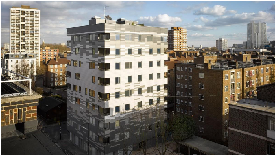
Figura 34. Prima construcție multietajată de locuințe din lume realizată integral din CLT: Murray Grove Stadthaus, Londra, UK.
