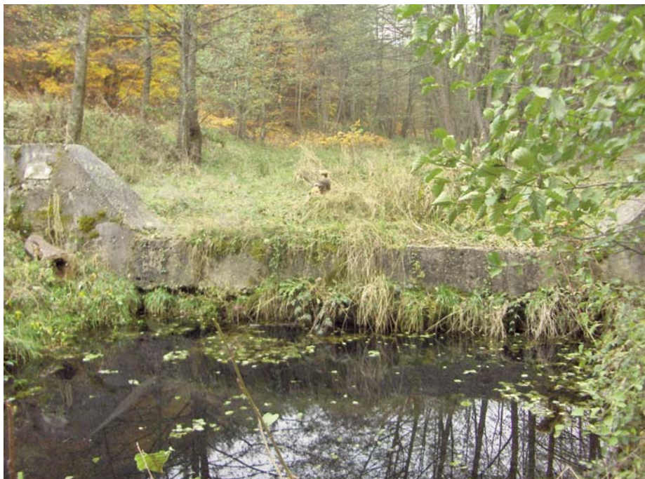
Fig. 6. 45 Lucrarea 1B1,0 de pe Valea Mălăieși scoasă parțial din funcțiune de evenimentul sufoziune (foto: Tudose 2009). The decrease in efficiency of works no 1B1.0 on Valea Malaiesi after it had been affected by suffusion (photo: Tudose, 2009)
