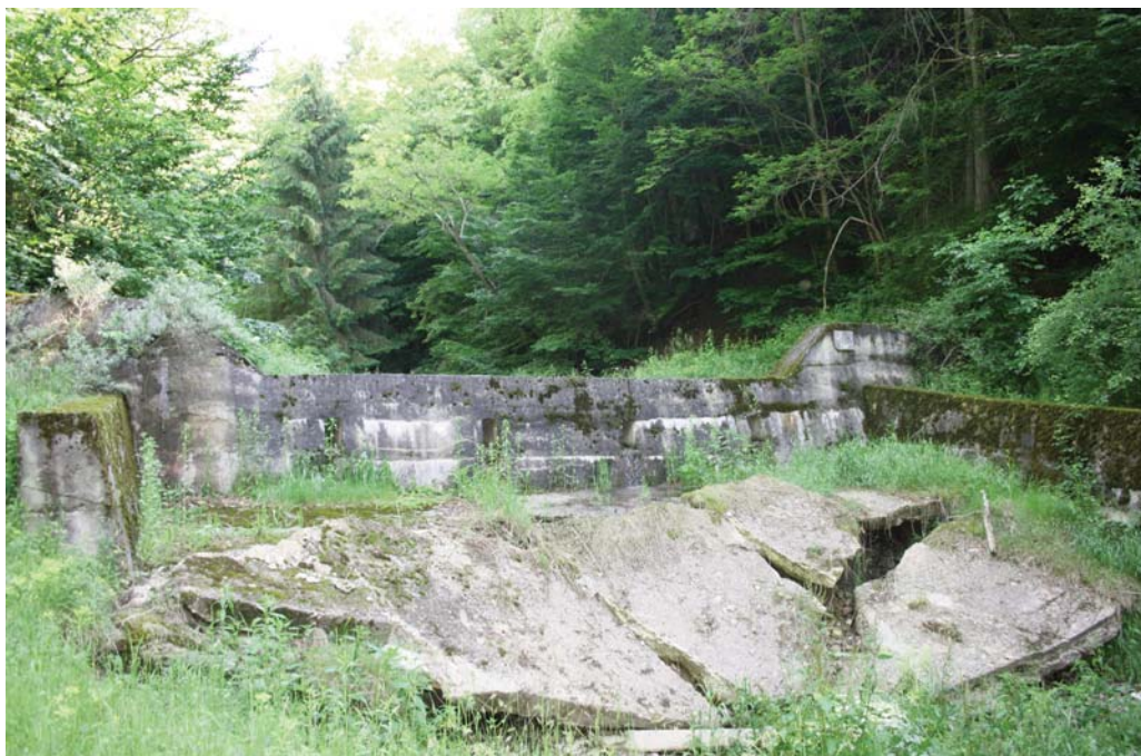
Fig. 6. 29 Pragul 13B1,5 de pe Valea lui Anghel afectat de ruperi ale radierului datorită subminării acestuia (foto: Tudose 2009). Sill no 13B1.5 on Valea lui Anghel affected by breaks (photo: Tudose 2009)
