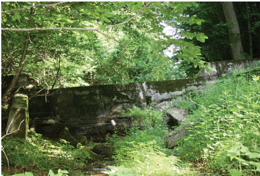
Fig. 6. 44 Scoaterea parțială din funcțiune a lucrării 12B1,5 de pe Valea Anghel prin evenimentul ruperi (foto: Tudose 2009). Significant decrease in efficiency of works no 12B1.5 on Valea lui Anghel after it had been affected by breaks (photo: Tudose 2009)
