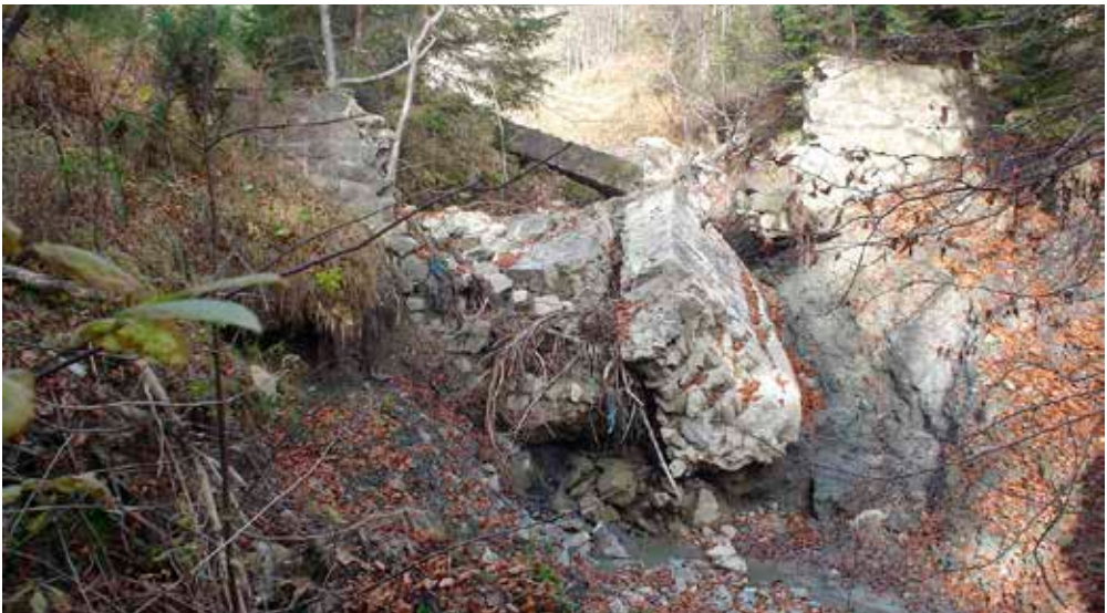
Fig. 4.3. Barajul 40M2,0 -stare foarte rea- de pe Valea Ialomicioarei (B.H. Ialomița), distrus în totalitate, având un indice de stare Y_s=3,2 (foto Gancz, 2009).
