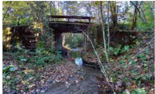
Fig. 5.4. Podeț dalat de traversare a Văii Adâncă de Jos (foto Mihalache, 2020).
