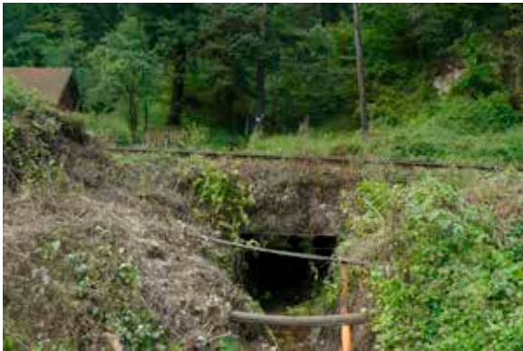
Fig. 5.44. Podeț la Magistrala CFR 500 care interceptează apele din BH Răchițeaua (Tudose et al., 2020).
