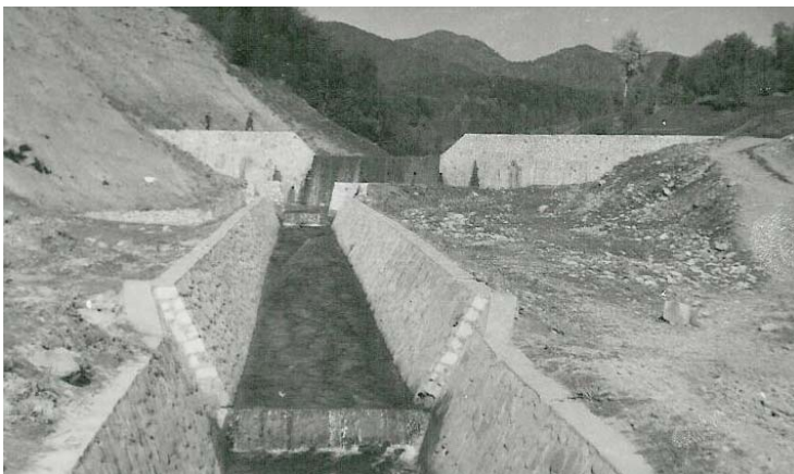
Foto 6.12 a Baraj din zidărie de piatră cu mortar cu pereu trapezoidal pe Valea Neagră – Herăstrău (foto N. Bogdan 1969)
