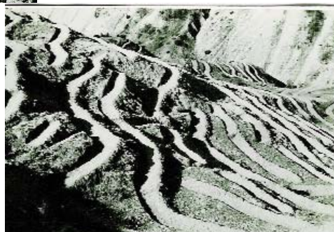
Foto 5.4 b Teren pregătit în terase simple nesuținute, perimetrul Roșoiu (foto N. Bogdan 1963)
