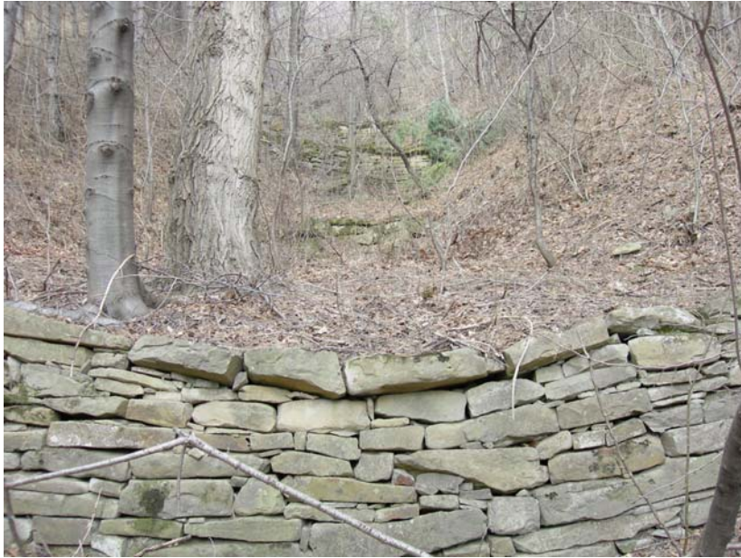
Foto 6.2 c Suită de praguri din piatră uscată pe o ravenă din perimetrul Scaune – executate în anul 1960 (foto S. Nistor 2007)
