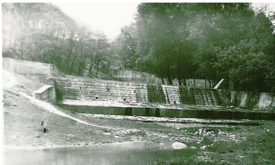
Foto 6.7 c Baraj din zidărie de piatră cu mortar pe o ravenă din Măgura Odobești – aterisamentul împădurit (foto N. Bogdan 1969)
