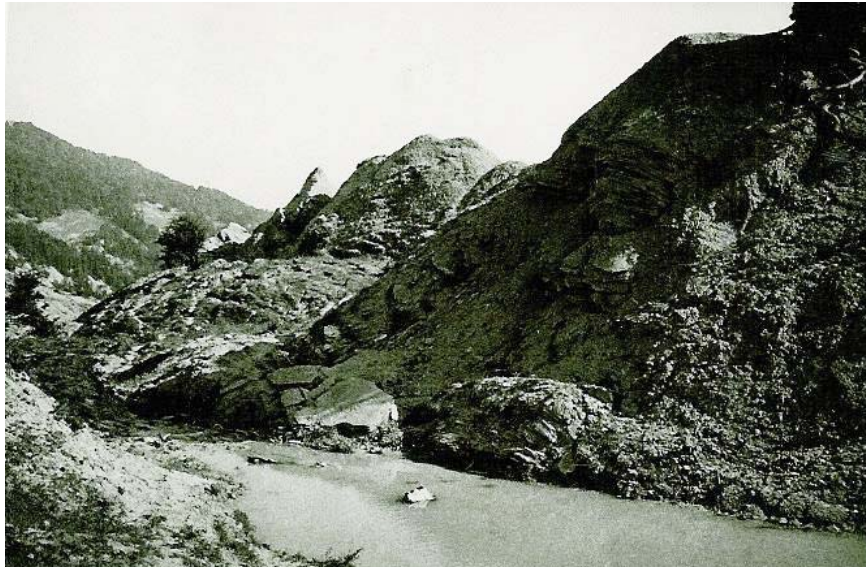
Foto 4.8 Alunecări de teren, la obârșia torentului Roșoiu (foto N. Bogdan 1963)
