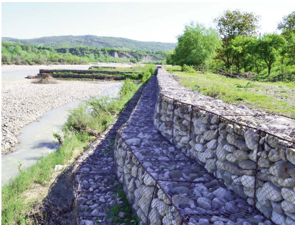
Foto 6.3 Praguri din gabioane și pinteni din gabioane pe Valea Putnei, în aval de Vidra (foto S. Nistor, C. Constandache, N. Bogdan 2014)
