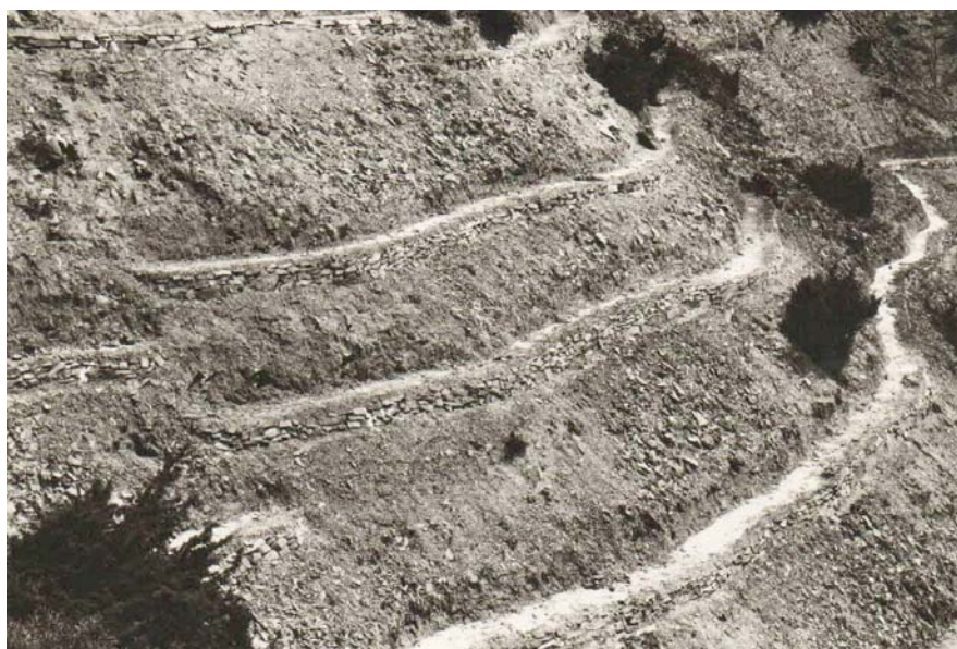
Foto 5.11 Terase susținute de banchete din zidărie de piatră, perimetrul Andreiașu (foto N. Bogdan 1963)
