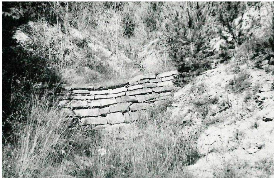
Foto 6.2 b Prag din piatră cioplită cu deversor în semilună pe o ravenă de pe valea Nărujei (foto N. Bogdan, 1962)
