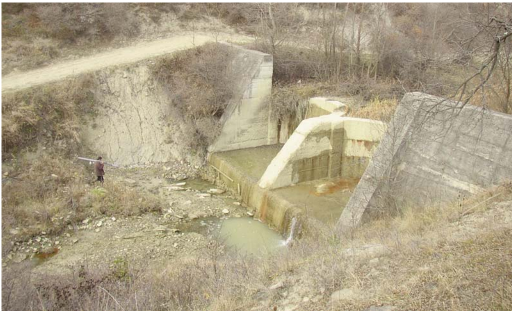
Foto 6.8 Baraj cu contraforți pe torentul Caciuleni executat în anul 1984-1985 (foto S. Nistor 2007)
