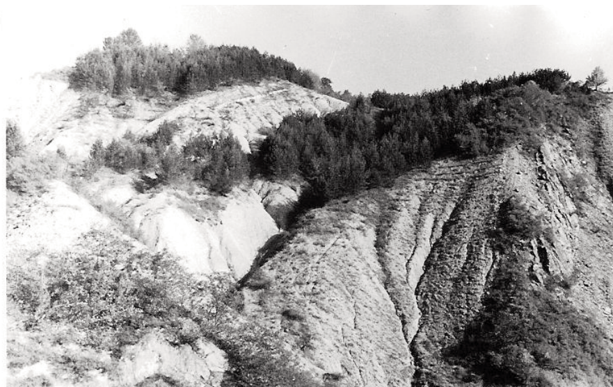
Foto 5.1 Plantații reușite numai pe terenuri cu pantă redusă din perimetrul Bârsești-Caciu (foto N. Bogdan 1964)
