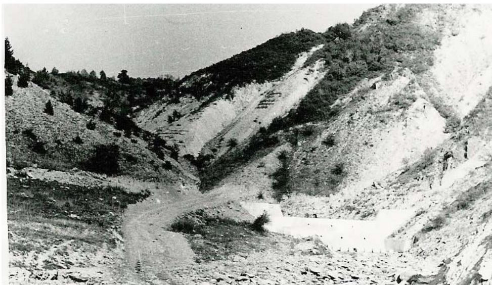
Foto 6.4 b Baraj din zidărie de piatră cu mortar pe torentul Caci-Bârsești-Putna (foto N. Bogdan 1963)
