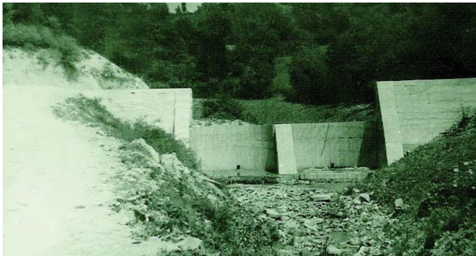
Foto 6.14 a Baraj de greutate din beton armat pe valea Reghiu– aterisamentul împădurit (foto N. Bogdan, 1968)
