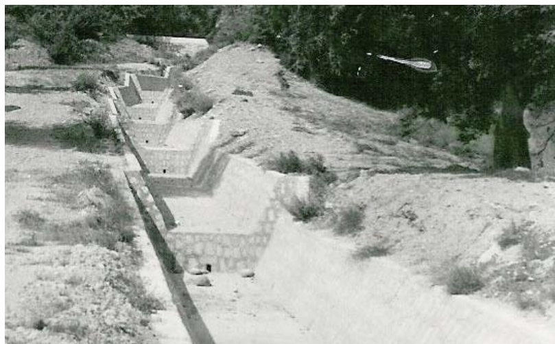
Foto 6.12 b Canal de scurgere în trepte pe o ravenă din zona de nord – Măgura Odobești (foto N. Bogdan 1967)
