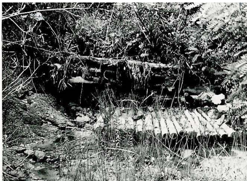
Foto 6.1 Prag din lemn, cu radier longitudinal din piese necarosate pe o ravenă de pe valea Nărujei (foto N. Bogdan 1958)
