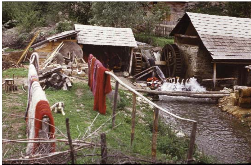
Foto 8.19 (c) Instalație pe apa Zăbalei (piuă și hultoare) pentru preparat stofe și cergi din lână (foto N.Bogdan 1956)
