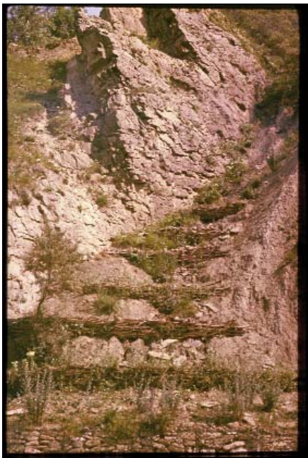
Foto 5.6 c Gărdulețe executate pe fundul unei ravene de pe valea Milcovului (foto N. Bogdan 1975)
