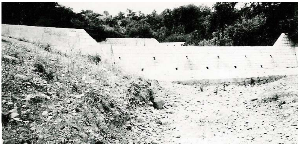
Foto 6.9 Baraj din zidărie de piatră cu mortar fără radier, pe o ravenă de pe versantul nordic Măgura Odobești (foto N. Bogdan 1968)
