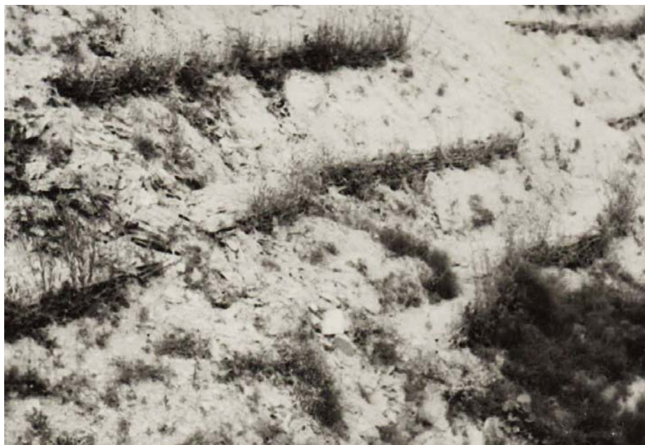
Foto 5.8 Terasse susținute de gârdulețe din nuietele verzi de salcie, intrate în vegetație, primetrul Andreiașu (foto N. Bogdan 1965)
