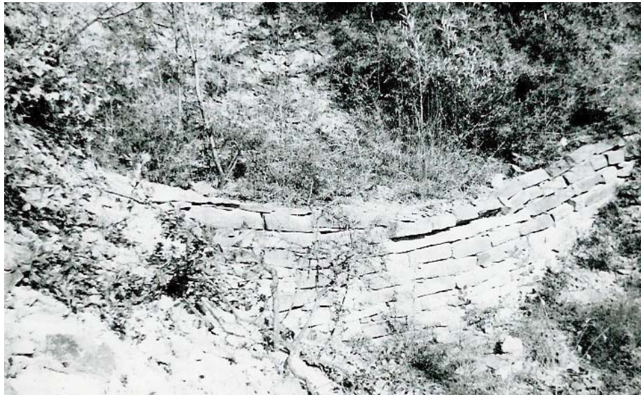
Foto 6.2 a Prag din piatră cioplită cu deversor în semilună pe o ravenă de pe valea Nărujei (foto N. Bogdan, 1959)
