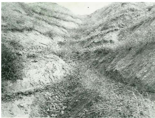
Foto 5.16 Terenuri excesiv degradate, consolidate cu terase armate vegetal în perimetrul experimental Bârsești – Vrancea (foto E.Untaru 1979)
