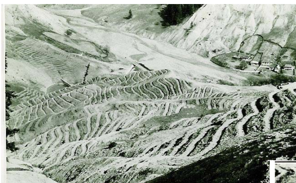
Foto 5.4 a Teren pregătit în terase simple nesuținute, perimetrul Andreiașu (foto N. Bogdan 1963)
