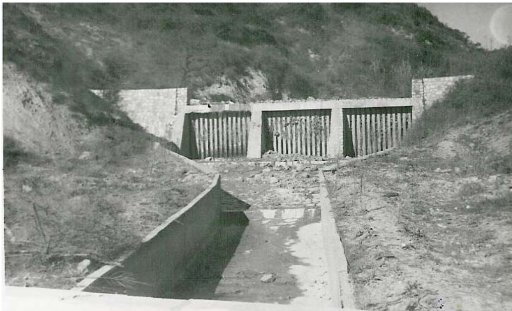
Foto 6.10 c Baraj filtrant din grile pe torentul Valea Nărujei (foto N. Bogdan 1967)
