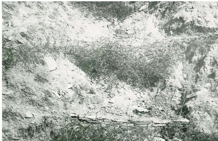
Foto 6.2 d Praguri din piatră cu radier vegetativ pe ogașe, continuate cu terase armate pe versanți în perimetrul experimental Bârsești – Vrancea (foto E. Untaru 1978)
