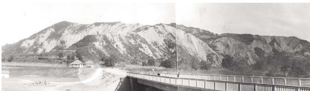
Foto 7.20 a Punctul Grumaz-Râpa Dracului cu podul peste valea Putnei (foto N. Bogdan 1962)
