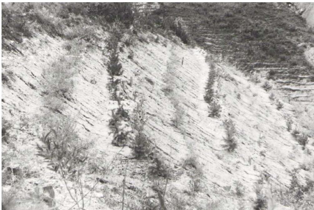
Foto 5.10 Plantație de pin pe terase susținute de gărdulețe în alternanță cu plantații de cătină pe terase înguste în cordon - primetrul Andreiașu (foto N. Bogdan 1966)
