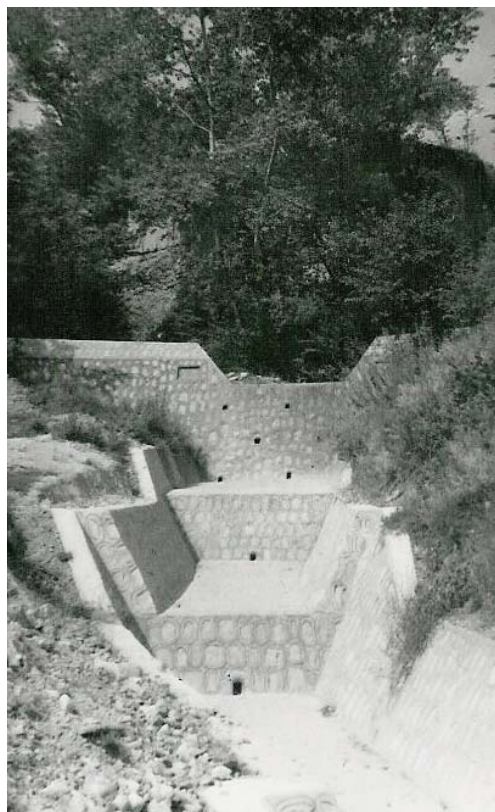
Foto 6.11 b Baraj cu radier în trepte pe o ravenă din Jariștea-Măgura Odobești (foto N. Bogdan 1969)
