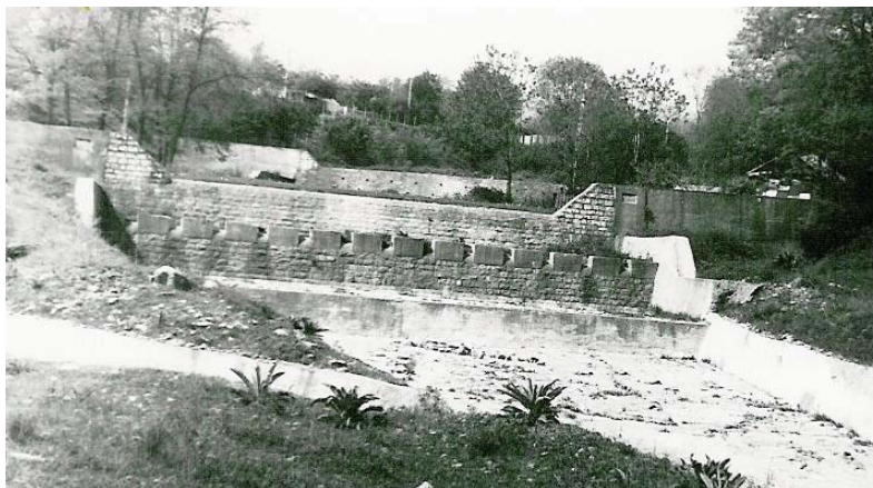
Foto 6.13 Baraj pe o ravenă din nordul Măgura Odobești cu aterisamentul împădurit (foto N. Bogdan 1970)
