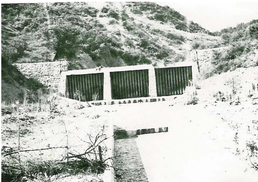
Foto 6.10 a Baraj filtrant din grile pe torentul Văcărie – Valea Nărujei (foto N. Bogdan 1967)
