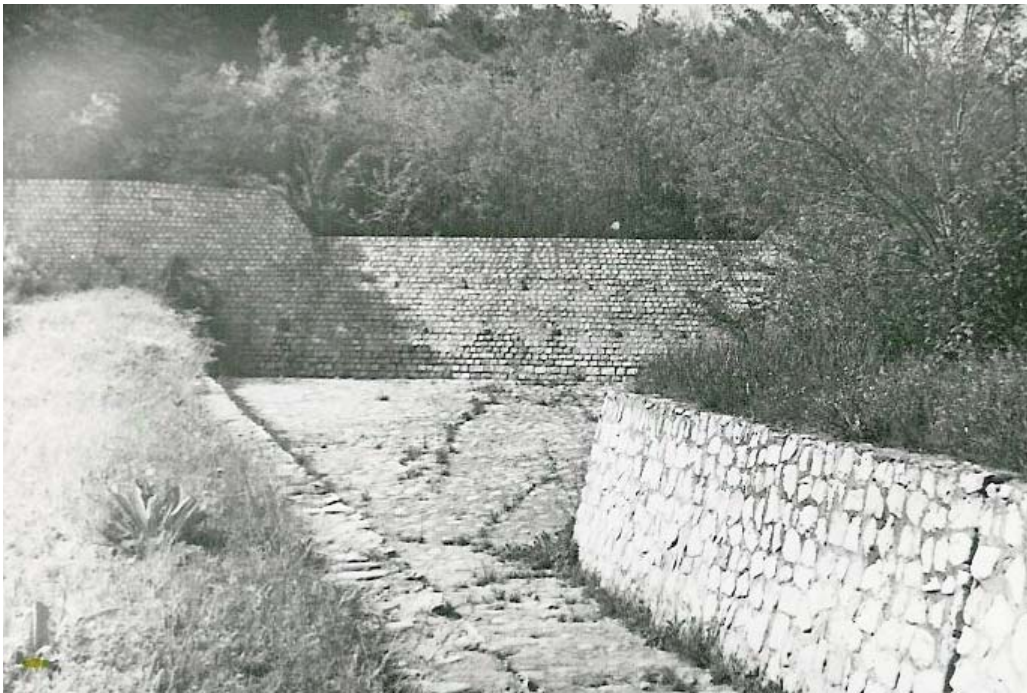
Foto 6.7 a Baraj cu pereuri din zidărie de piatră (foto N. Bogdan 1969)
