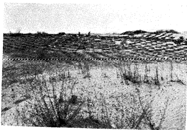
Fig. 32 și 33. — Aspecte ale unei dune, după terminarea lucrărilor de fixare.
