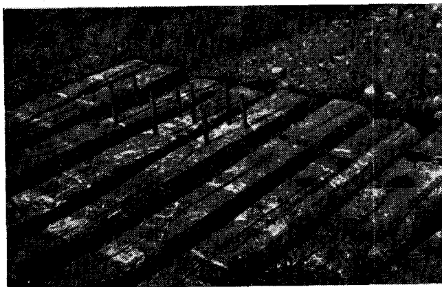
Fig. 9 — Baterea cepurilor peste cartușele antiseptice
