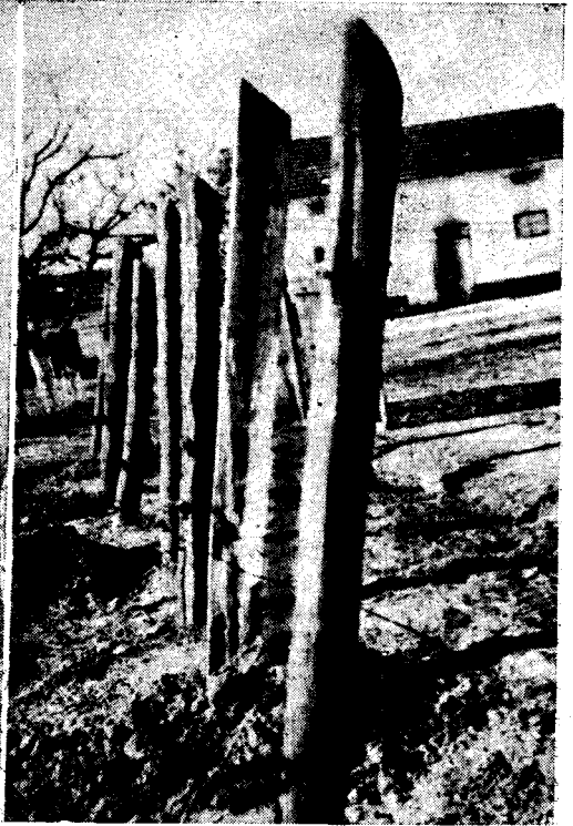
Fig. 3. Spaliere impregnate prin procedeul băi calde montate în vie la G.A.S. Pantelimon
