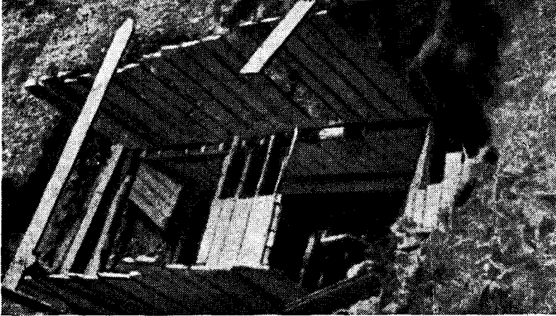
Fig. 12. — Sprinținirea pereților fundației prin palpanse.
